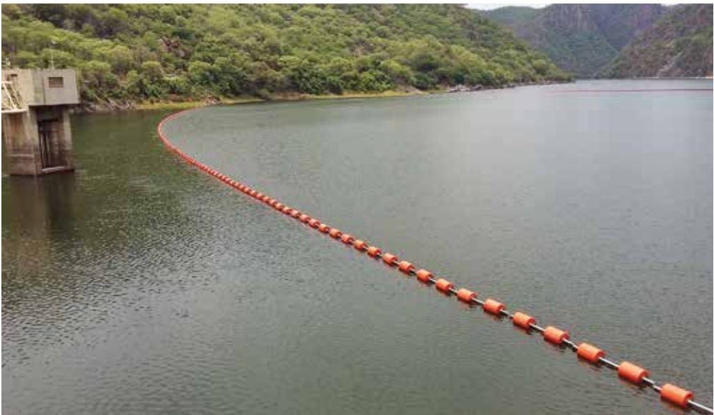
Die Treibgutbarrieren sind mit Schwimmern aus Kunststoff und ausgehärtetem PU-Schaum ausgestattet.
