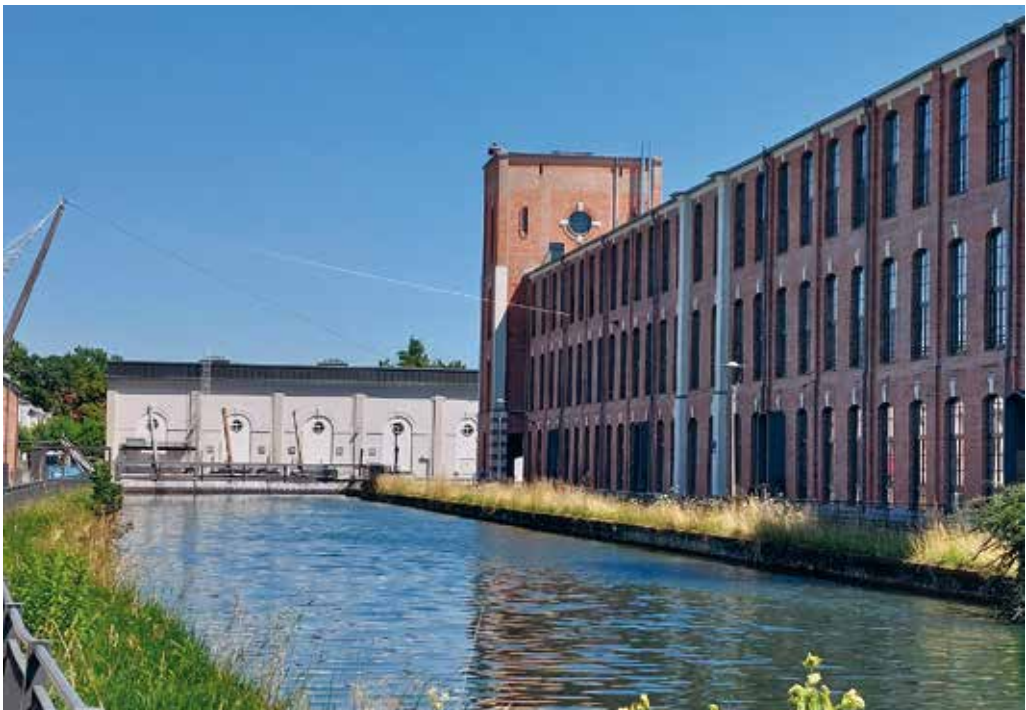
Das Wasserkraftwerk Unteres Werk in Kolbermoor wurde 1896 von der damaligen Baumwollspinnerei (rechts im Bild) gebaut. Foto: WVB, Ina Röpcke
