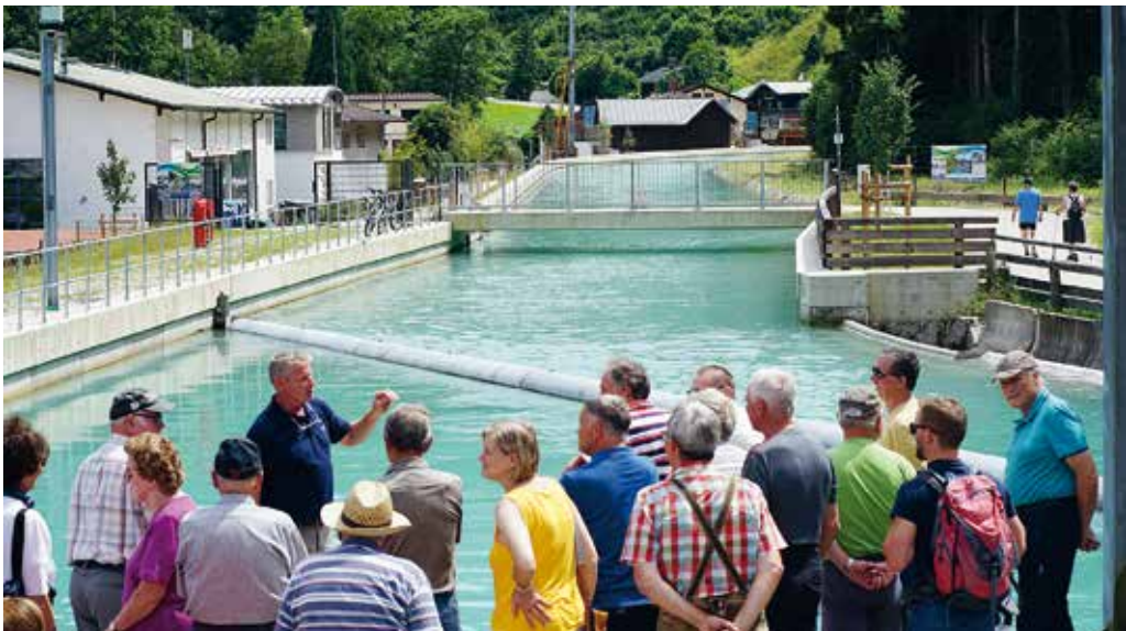
Das sanierte und modernisierte historische Wasserkraftwerk in Berchtesgaden-Gartenau zog Hunderte von Gästen an. Foto: AUF Eberlein & Co GmbH
